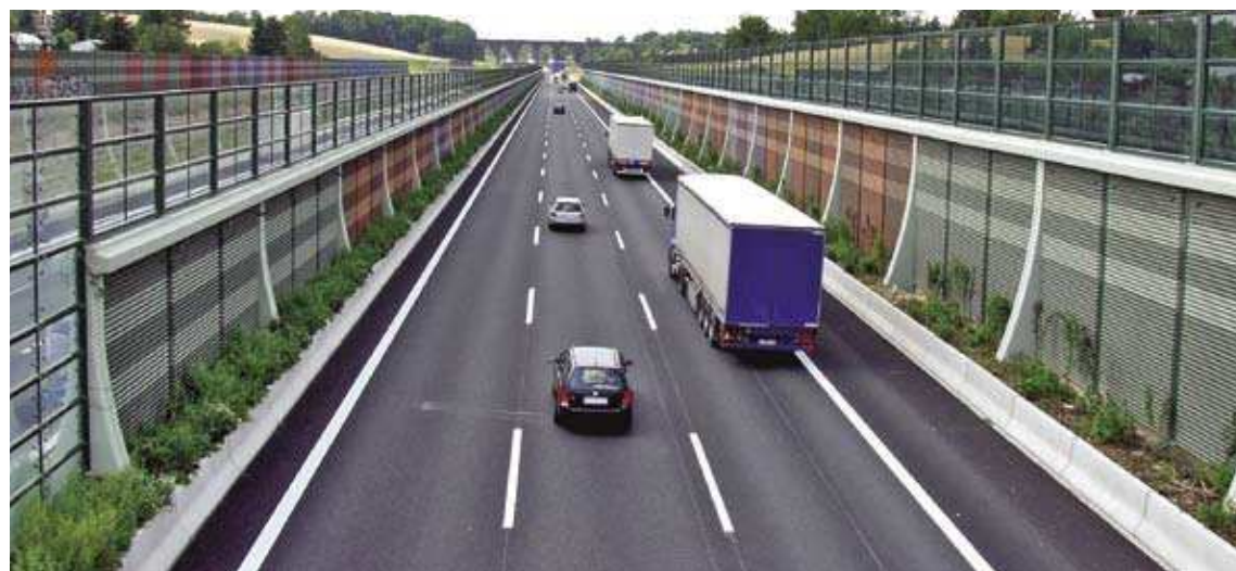
▲ Obr. 2. Protihlukové stěny Liadur – Chemnitz, Německo
