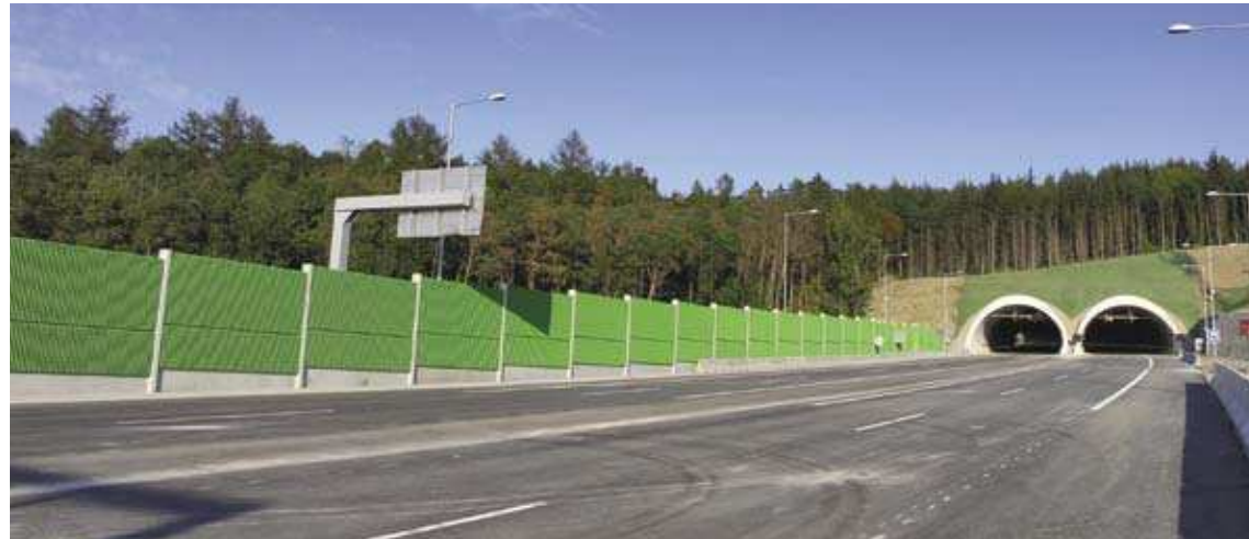
▲ Obr. 1. Protihlukové stěny Liadur – tunel Valík, Plzeň
