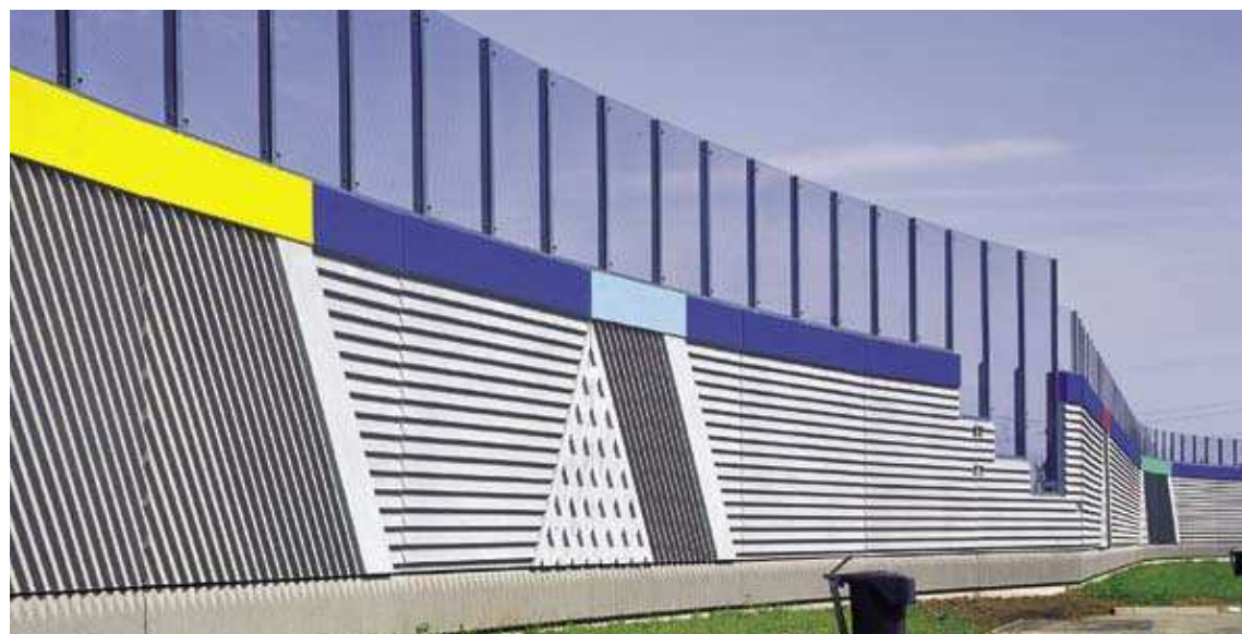
▲ Obr. 3. Protihlukové stěny Liadur – Vellern, Německo
